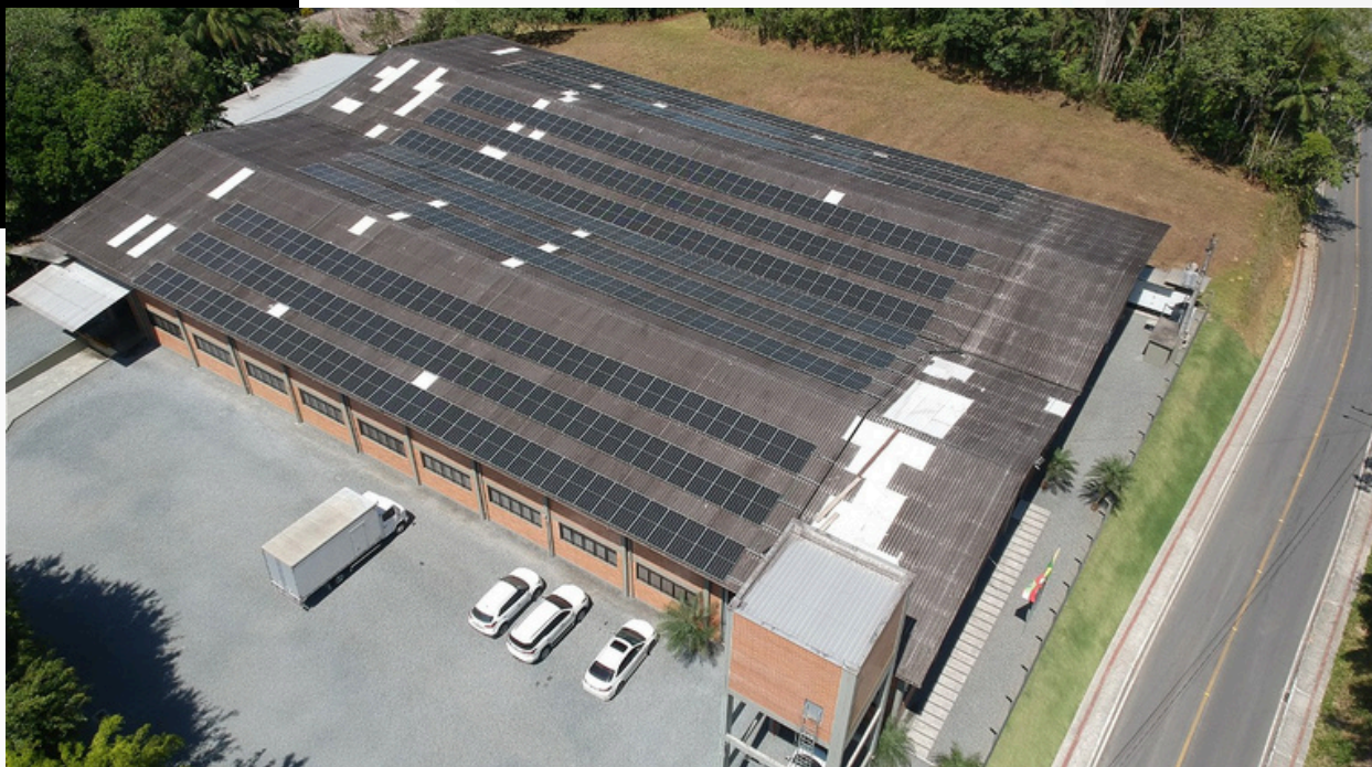
➤ IOPLAST Blumenau - Implementação de usina solar fotovoltaica.
